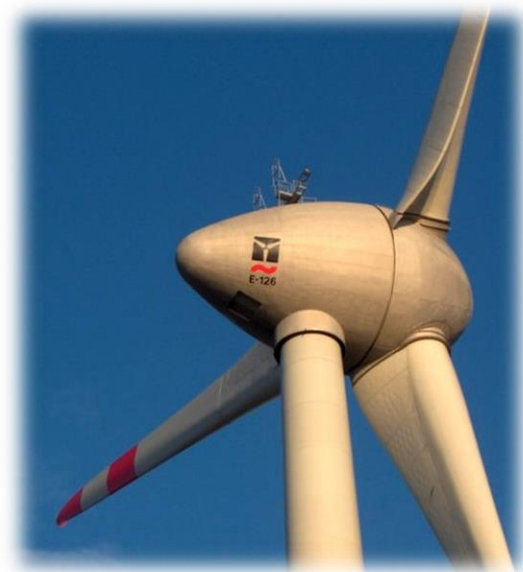
2009 E126 6 - 7.5 MW Stator Ø 12 m Terrestre
