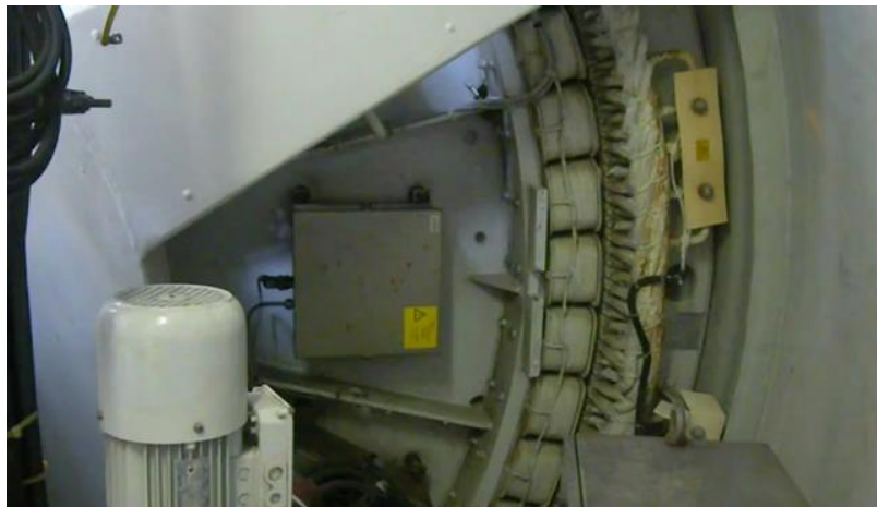
E48 750kW - démarrage
