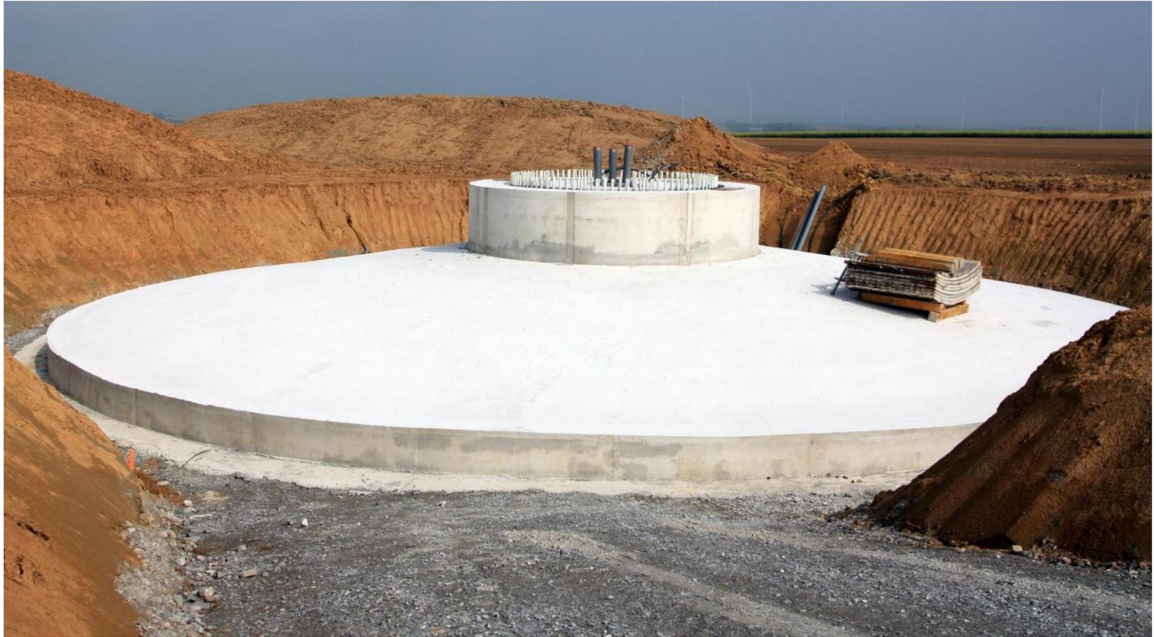
Socle en béton, environ 1300 tonnes de béton
