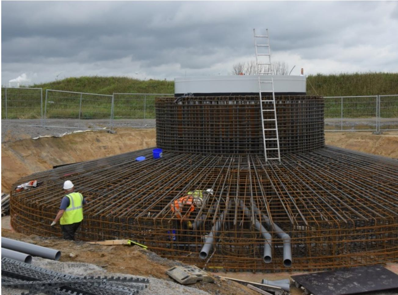
Armature du socle d'éolienne 50 tonnes
