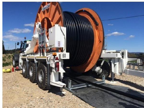
Déroulage du câble
