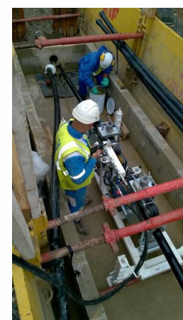
Jonction entre deux câbles
