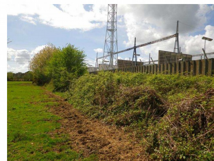
Exemple du poste électrique de Manuel
