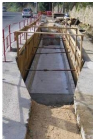
Chambre de jonction
