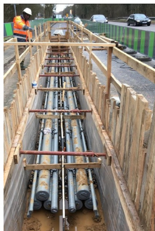
Travaux de génie civil
