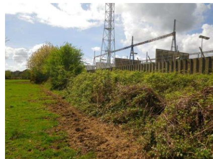
Exemple du poste électrique de Menuel
