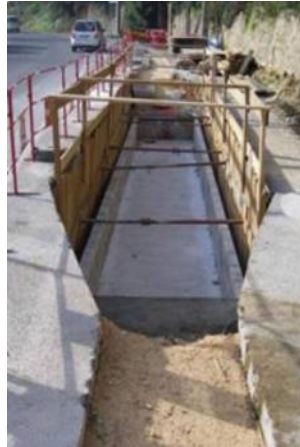
Chambre de jonction
