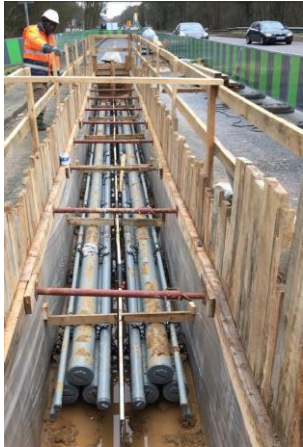
Travaux de génie civil
