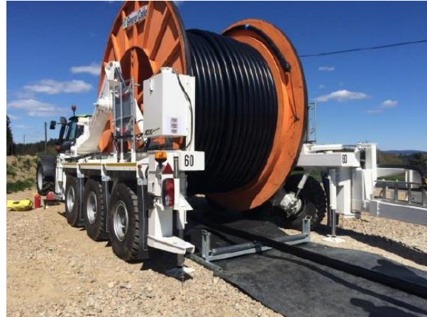
Déroulage du câble
