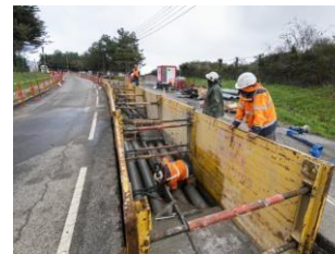
Câbles souterrains sous voirie
