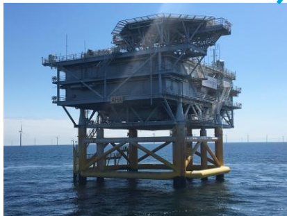
Poste électrique en mer
